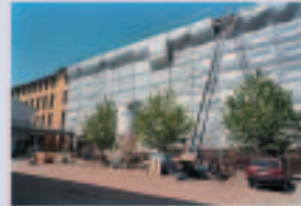
Das Gerüst im Innenhof wird gestellt
