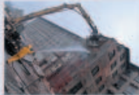
März 2011: Der Anbau wird abgerissen
