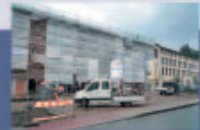
Gerüstbauarbeiten an der Außenfassade
