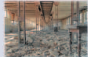
Die Stahlträger werden freigelegt
