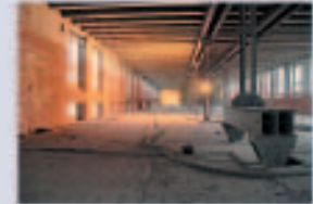
Die Innenwände wurden sandgestrahlt
