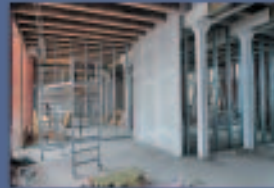
Ausbau des Erdgeschosses
