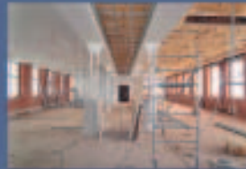
Innenausbau der 1. Obergeschos
