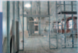
Juni 2011: Trockenbauarbeiten im Dachgeschoss
