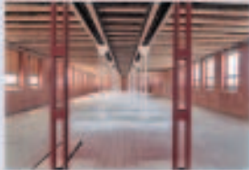
Brandschutzanstrich der Säulen
