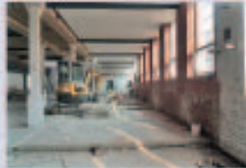
Das Erdgeschoss wird entkernt
