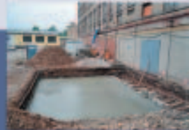
Das Fundament für das neue Treppenhaus
