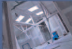
3. OG: letzte Phase des Ausbaus
