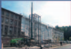
August 2011: Errichtung des Treppenturms
