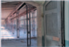
Etage für Etage wird entkernt
