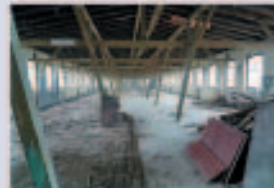
Februar 2011: Die Dielung wird entfernt
