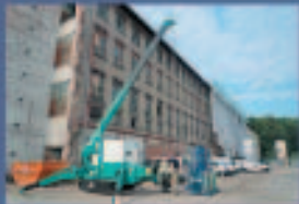
Glasscheiben werden in das 3. OG transportiert
